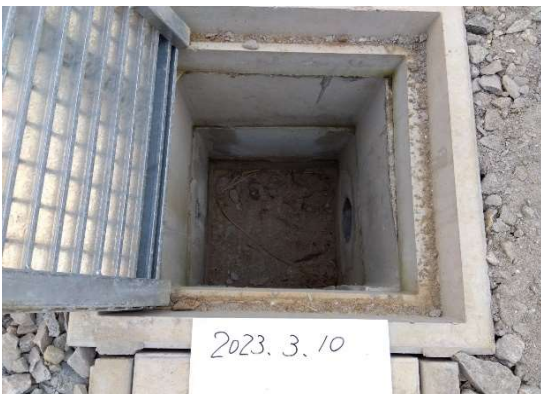
最終集水桝（場内）
