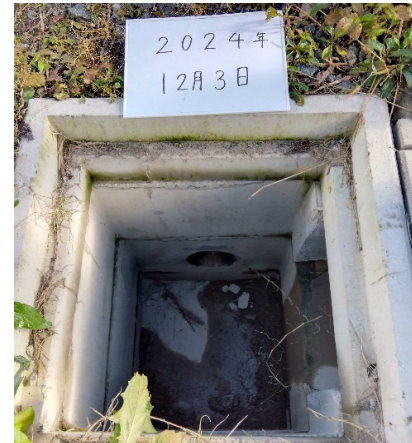
最終集水桝 (場内)
